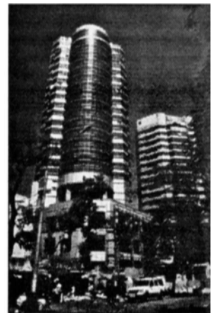
Khách sạn Trung tâm Hà Nội, 44B phố Lý Thường Kiệt, do một tập thể kts Thái Lan thiết kế, Công ty France Architects thực hiện năm 1997.
