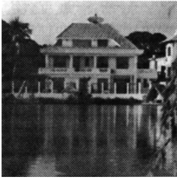
Biệt thự cao cấp xây sát mép nước hồ Tây ở Quảng Bá.
