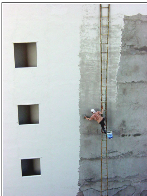
Công trường (ảnh N. A. L.)
